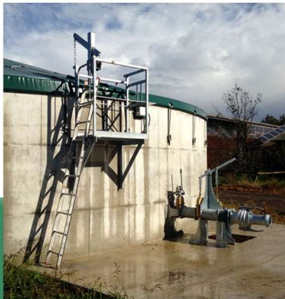
bezpośrednio przez ścianę
